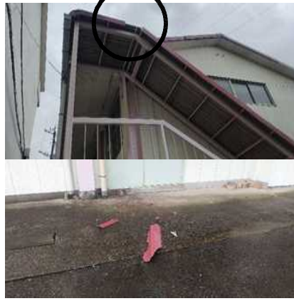
【破損した技術棟階段屋根と落下物】【破損した倉庫壁と落下物】
