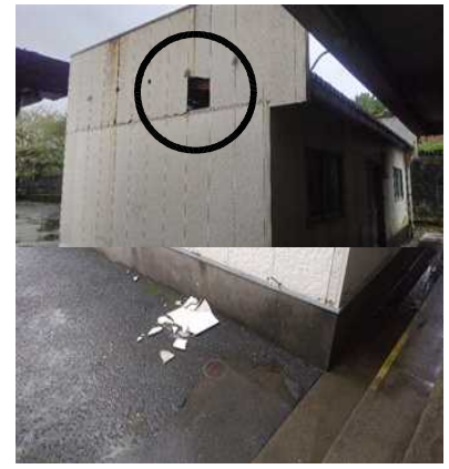
【破損した技術棟階段屋根と落下物】【破損した倉庫壁と落下物】
